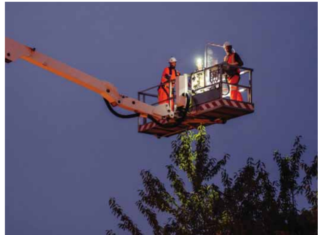
Mantenimiento de postes altos
